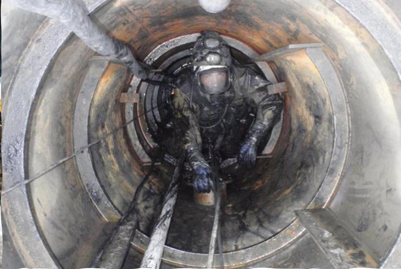
Application d'un complexe de résistance mécanique sur conduites
